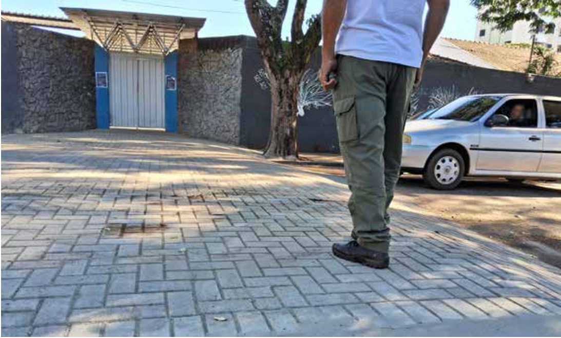
Travessia elevada recém construída em frente ao Colégio Estadual Costa Monteiro: “travessia segura”
